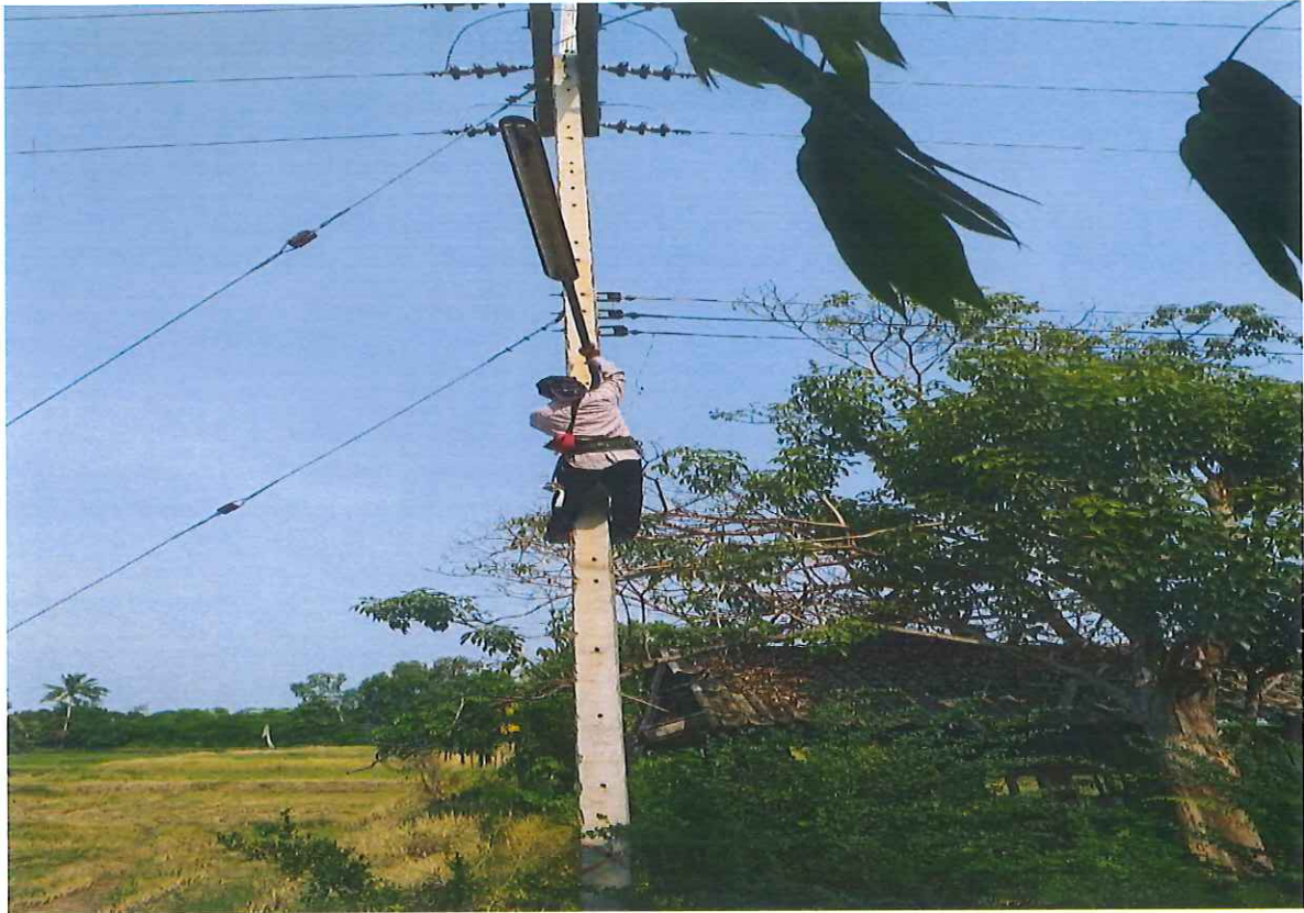
ภาพถ่ายขณะดำเนินการแก้ไขปัญหาความเดือดร้อน ซ่อมแซมไฟฟ้าสาธารณะ บริเวณหน้าบ้าน นางหนูเพียร โกฏีรักษ์ ประชาชน บ้านขม้น หมู่ที่ 5 ตำบลนาดี อำเภอยางตลาด จังหวัดกาฬสินธุ์ ในวันที่ 7 พฤษภาคม 63
