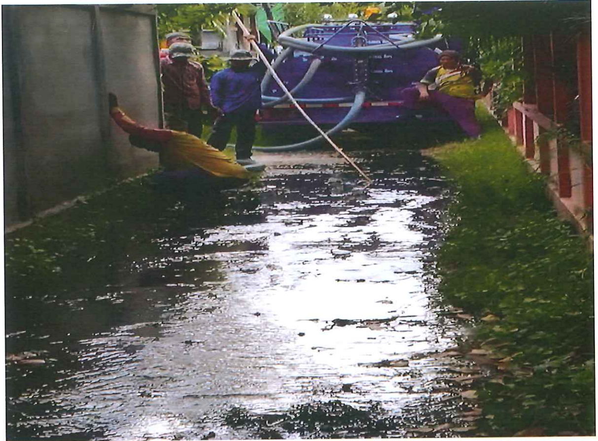
ภาพถ่ายขณะดำเนินการแก้ไขปัญหาคความเดือดร้อน บริเวณบ้าน นายเฉลิม ภูขมัง บ้านปอแดง หมู่ที่ ๒
