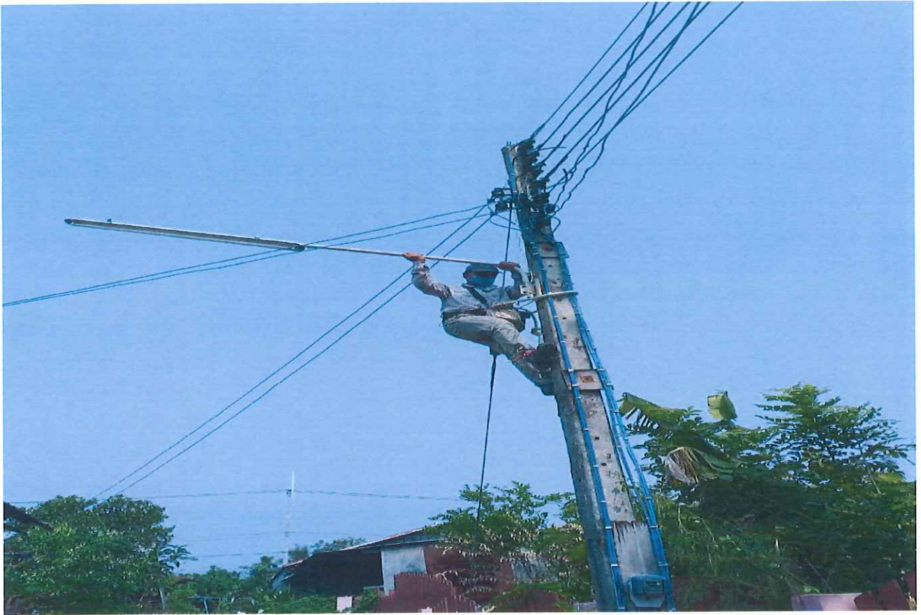
ภาพถ่ายขณะดำเนินการแก้ไขปัญหาความเดือดร้อน ซ่อมแซมไฟฟ้าสาธารณะ บริเวณหน้าบ้าน นางไพฑูรย์ ศรีจำปา ประชาชน บ้านปอแดง หมู่ที่ 2 ตำบลนาดี อำเภอยางตลาด จังหวัดกาฬสินธุ์ ในวันที่ 8 เมษายน 2563
