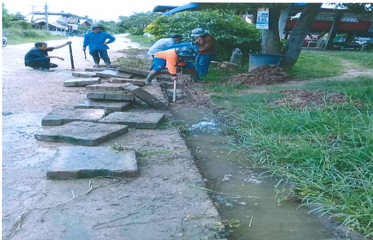
ภาพถ่ายขณะดำเนินการแก้ไขปัญหาคความเดือดร้อน ร่องระบายน้ำ คสล. จากบ้าน นายพรชัย ภูประสิทธิ์ ถึงบ้าน นายไพรัตน์ ภูตะวัน บ้านปอแดง หมู่ที่ ๑
