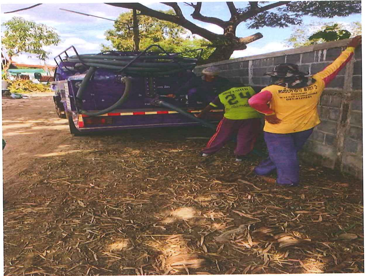
ภาพถ่ายขณะดำเนินการแก้ไขปัญหาคความเดือดร้อน ท่อระบายน้ำอุดตัน จากที่ นายประเทือง ภูขมัง ถึงคูส่งน้ำสาธารณะ บ้านปอแดง หมู่ที่ ๒
